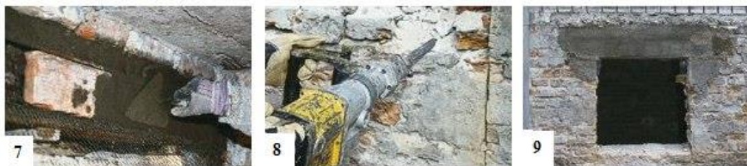
Fot. 6. Przykładowy sposób wykonania nadproża z zastosowaniem belek stalowych (materiały pochodzą z bazy strony muratordom.pl)
