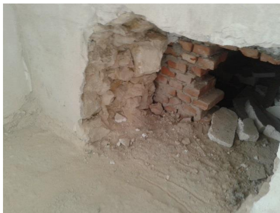
Fot. 2. Wewnętrzne ściany ceglano kamienne w najstarszej części.
