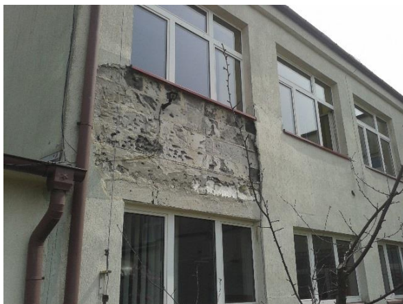
Fot. 1. Ubytki w tynku zewnętrznych.
