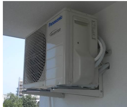
Fot. 7. Systemowy wspornik ścienny wraz z klimatyzatorem.
