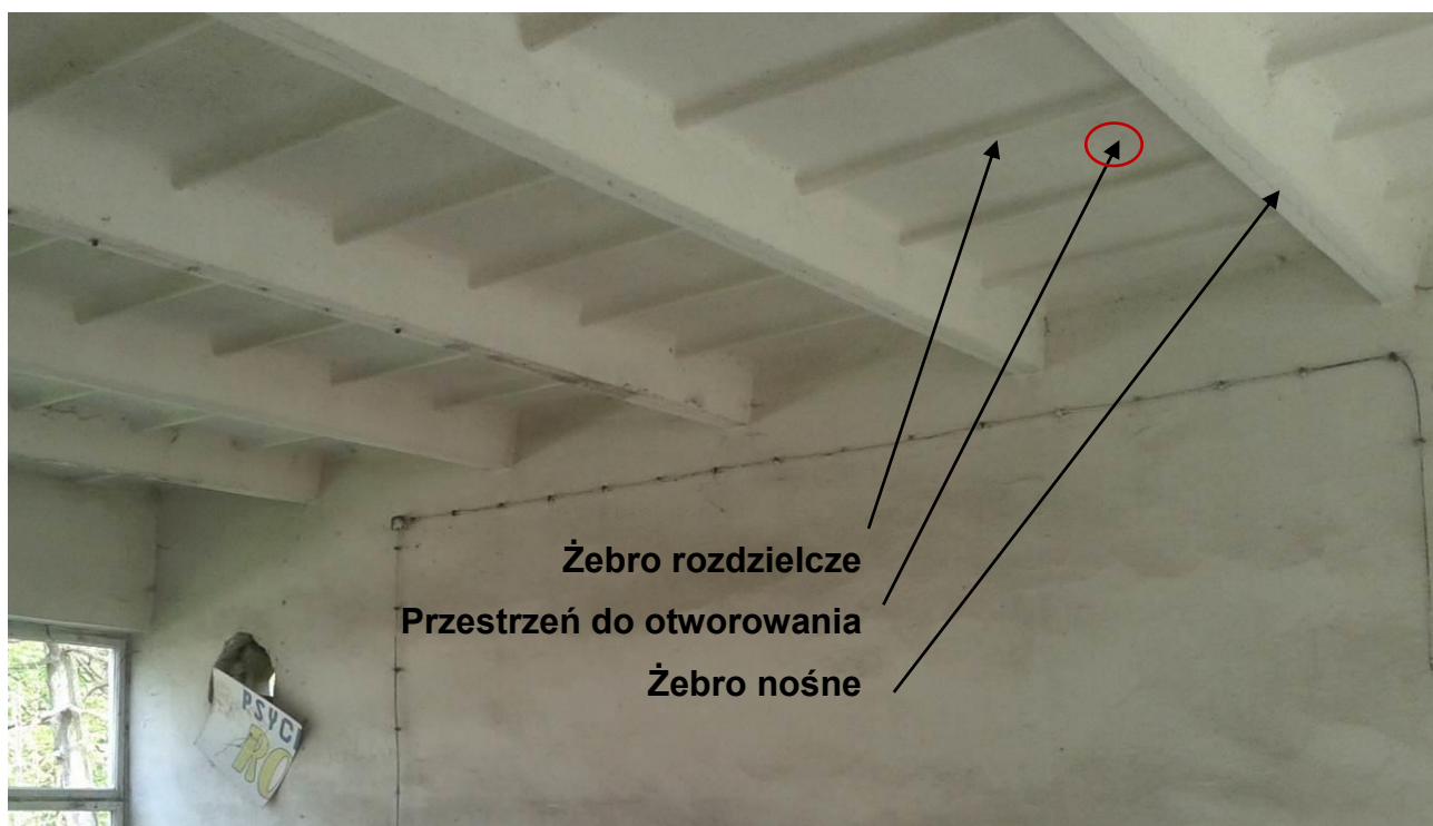
Fot. 9. Oznaczenie konstrukcji nośnej stropodachu oraz miejsce otworowania.
