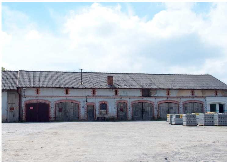
Widok budynku od północnego-wschodu
