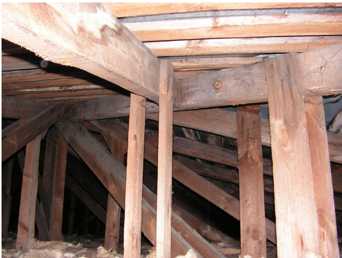
Zdjęcie autorskie Nr 1. Stropodach - wiązar deskowy - izolacja na dolnych pasach dźwigara, do zdjęcia po demontażu pokrycia z blachy i łat i ewentualnego wykorzystania
